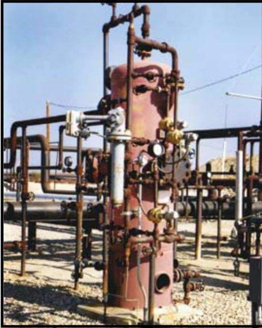
**Antes:** Un recipiente de proceso con 3 interruptores de flotador, 2 mirillas de cristal, un controlador de nivel neumático y 15 válvulas con la tubería asociada.
