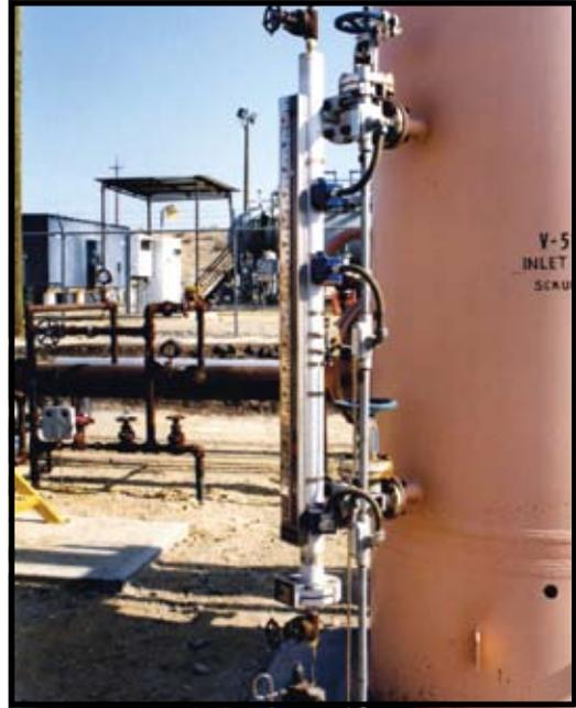
**Después:** El mismo recipiente del lado izquierdo después de instalar un indicador de nivel Magtech, mejora el control del proceso, reduce el costo de instalación y mantenimiento al cliente.
